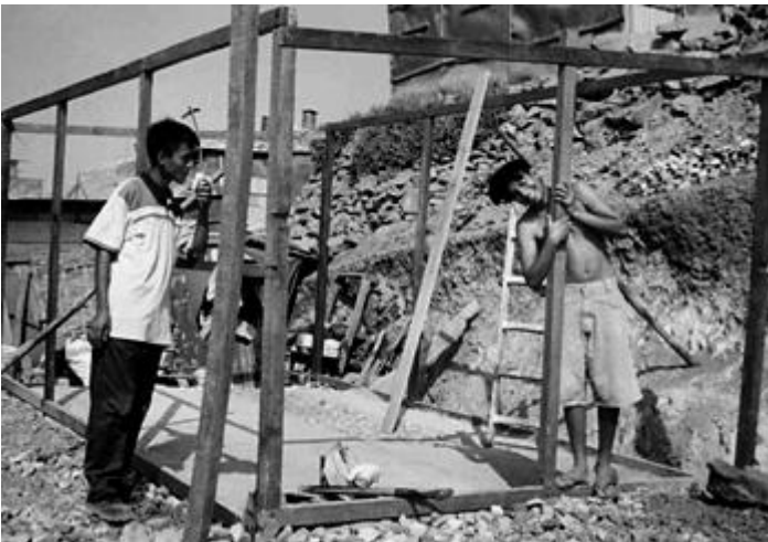
Walter (links) und Javier mit dem "Rohbau"
